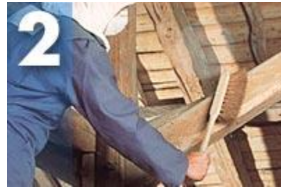
Brossage de la charpente
