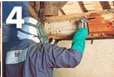
Injection en profondeur
