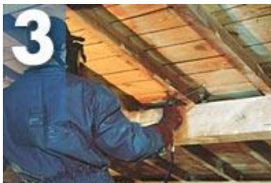
Pulvérisation du gel à haute pression
